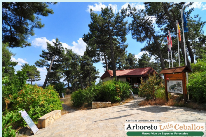
Instalaciones CEA Arboreto Luis Ceballos
