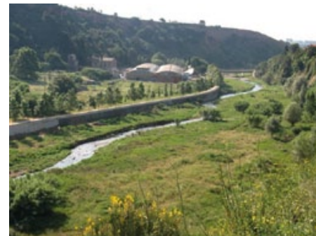
Aspecto inicial de la mayor parte del tramo del río Ripoll donde se realiza el proyecto. En la fotografía aún pueden observarse algunas masas de caña común (ya eliminadas). A la derecha también son visibles una serie de árboles (chopos, sauces, alisos) fruto de una pequeña plantación anterior (de 1999) del Ayuntamiento de Sabadell. © Juan Isidro Calderón.
